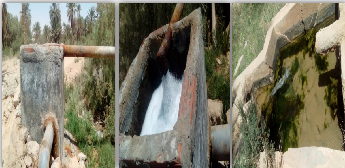
Figure 50: Forrage d'irrigation des palmeraies d'Oued Righ
