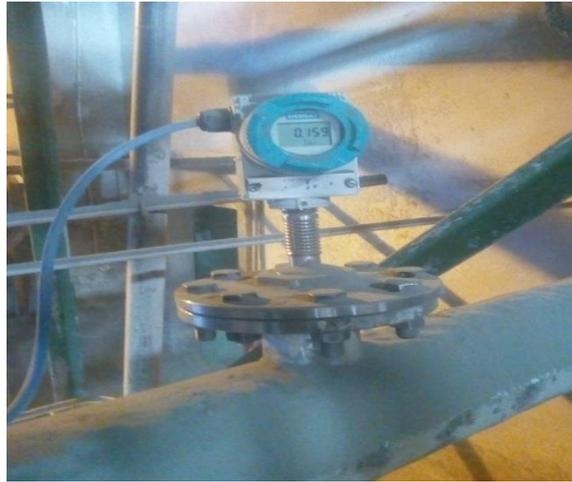
Fig.4.II : transmetteur de pression utilisés dans le système
