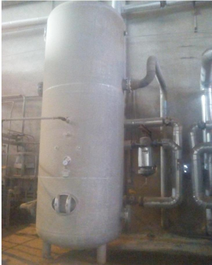
Fig. II.3 : Réservoir d'air comprimé
