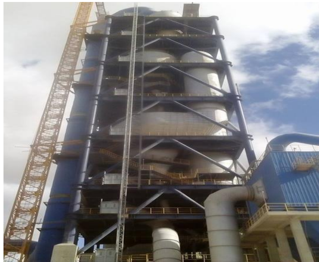
Figure 1.14:Préchauffeur ou cyclones
