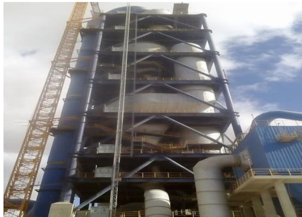
Figure I.9: Préchauffeur ou cyclones [1]
