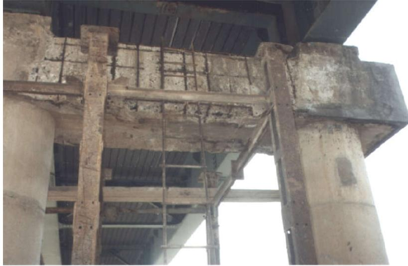
*Figure 1.16 : Délamination de la face d'une chevêtre d'un pont en béton armé.*
