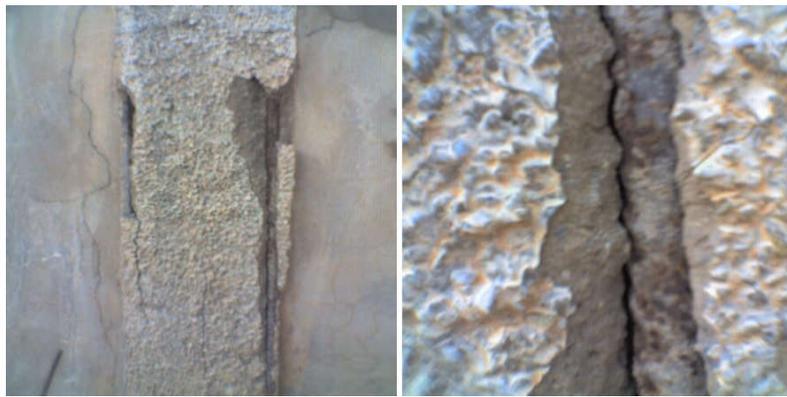
c) Corrosion d'armature.
