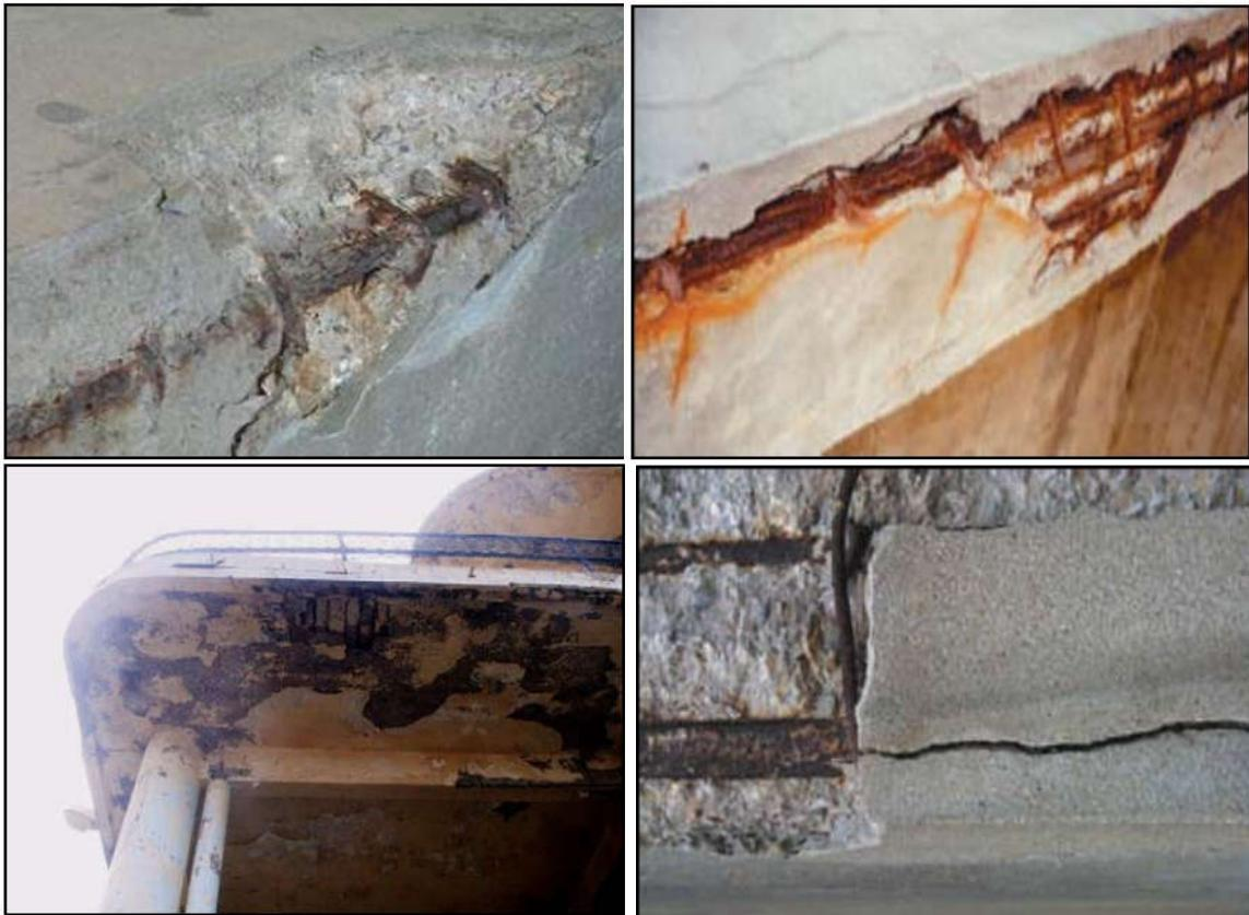
*Figure 1.8: Exemples de corrosion par carbonatation[5]*
