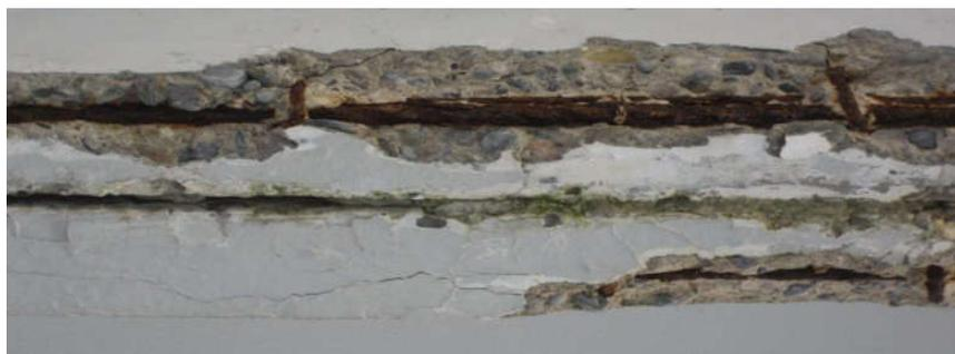
*Figure 1.6 : L'état de corrosion des armatures (par carbonatation) sur une poutre d'auvent en béton armé. [4]*
