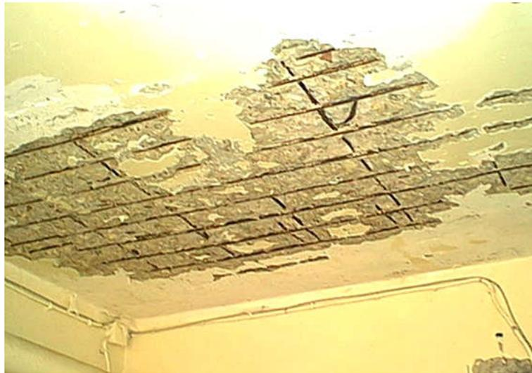
*Figure 1.15 : Délamination dues à la corrosion dans une dalle en béton armé [9]*
