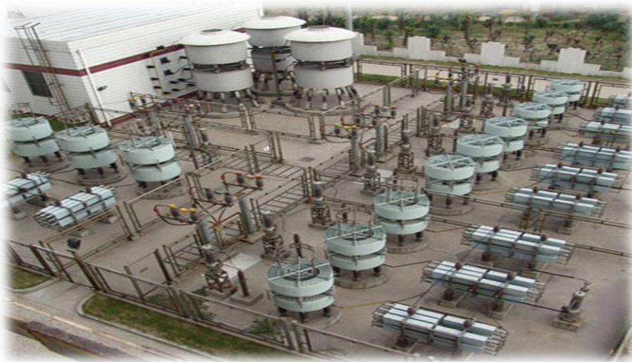
Figure 1.13 : les compensateurs statiques de l'énergie réactive
