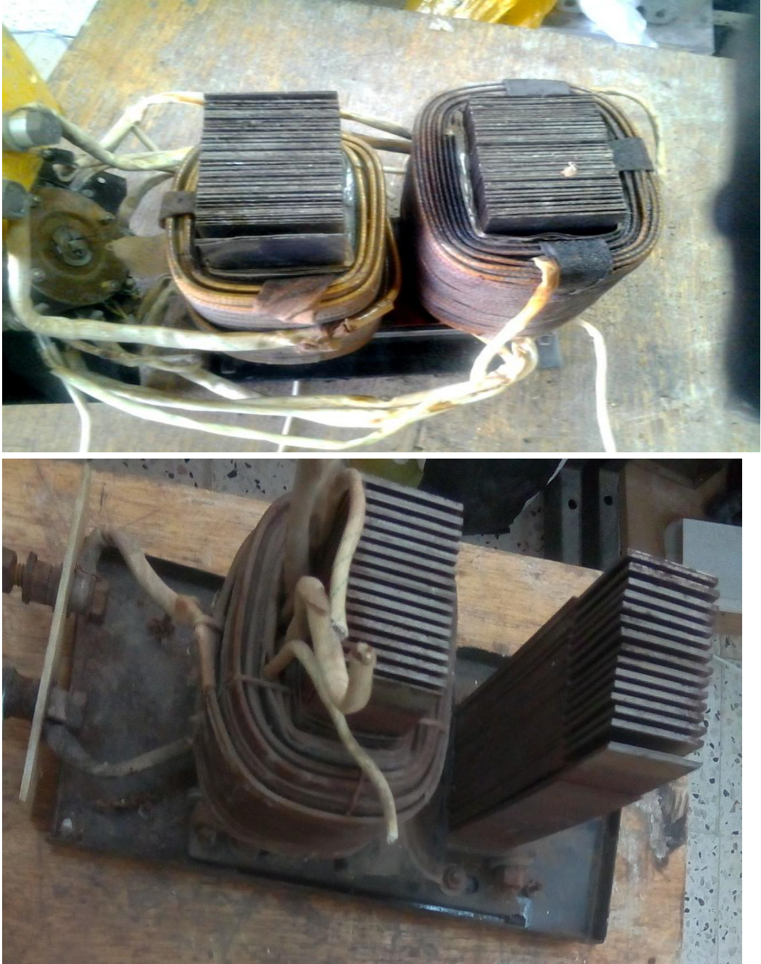
Fig. (III.3) : Démantèlement de la bobine primaire
