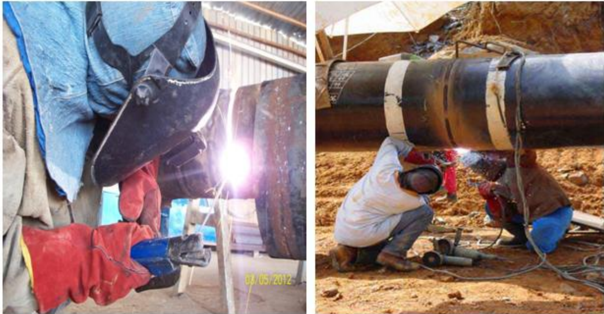
Fig. (I.8) : Soudage des pipelines (type manuel).
