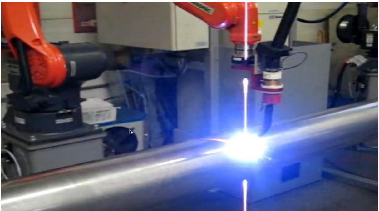
Fig. (I.9) : Soudage des pipelines type automatique.
