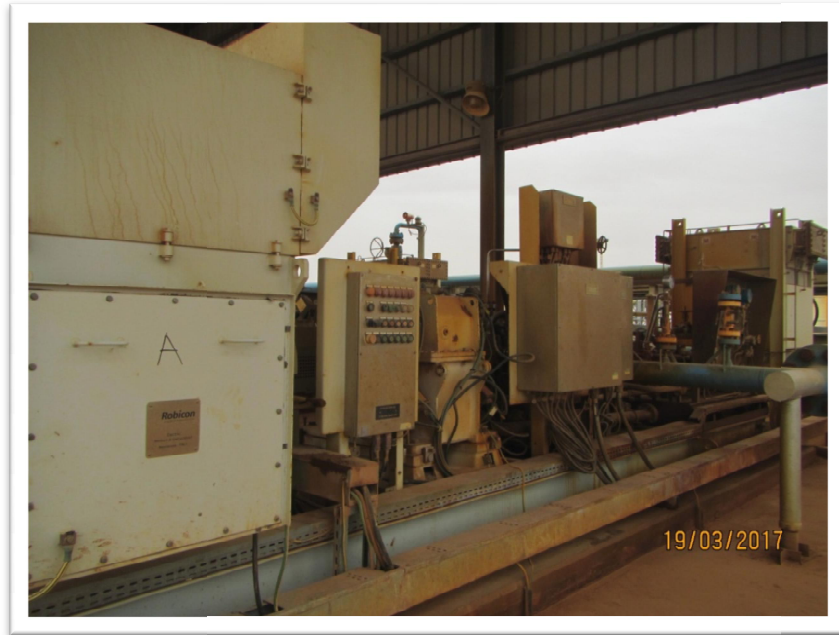
Figure III.23 : Pompe d'Injection d'Eau Produite.
