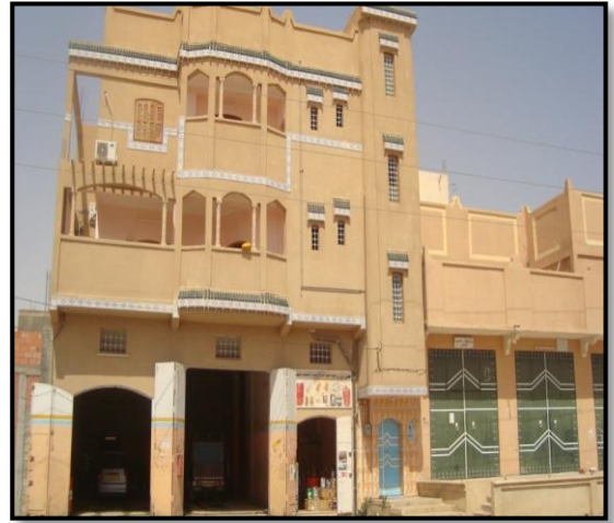
صورة رقم 1 : بناء حديث
