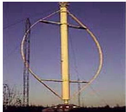
Figure 2 : Aérogénérateur à axe vertical
