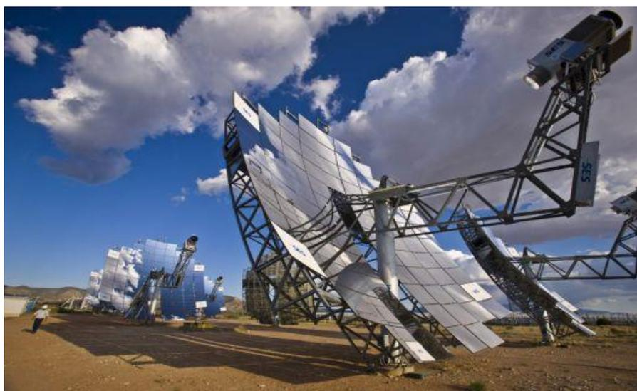
**Figure I-4:** Centrales à miroir parabolique Dish-Stirling
