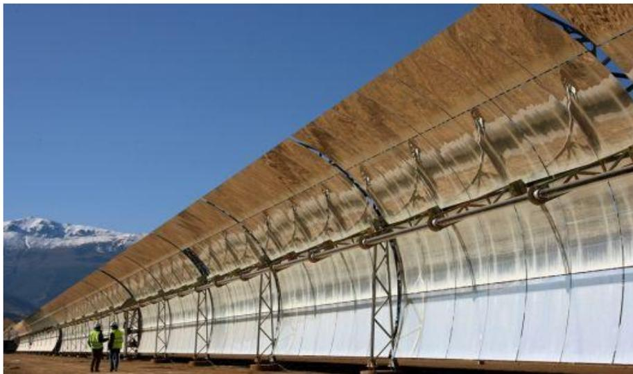
**Figure I-1:** Centrales à miroirs cylindro-paraboliques
