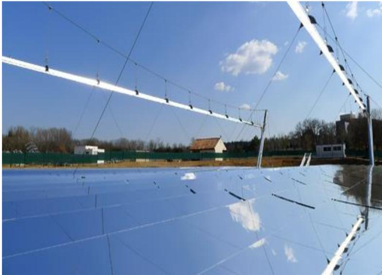
**Figure I-2:** Centrales solaires à miroirs de Fresnel
