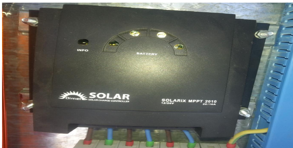
Fig. IV.7 le régulateur de charge
