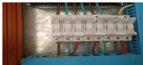
Fig. IV.4 Portes fusibles
