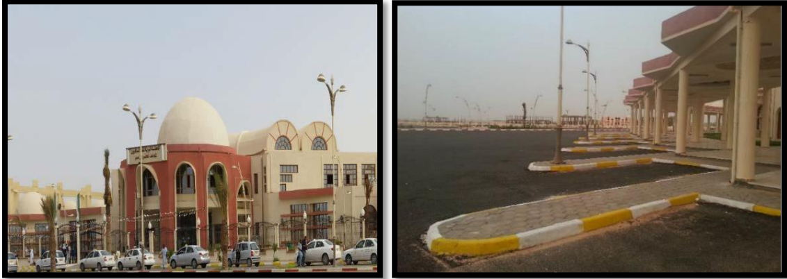
Figure 21 : Gare routière d'El Oued (réalisé par l'étudiante).
