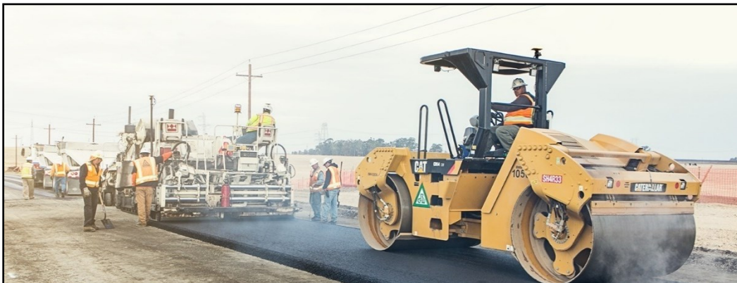
Photo IV-2: Le compactage d'enduit superficiel
