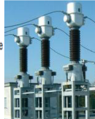
Figure III-26 : Type TC mesure coté HTA
