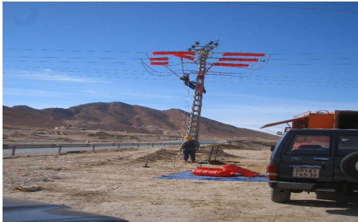
Fig.(2.1.3.2.19) : dépose les protecteurs
