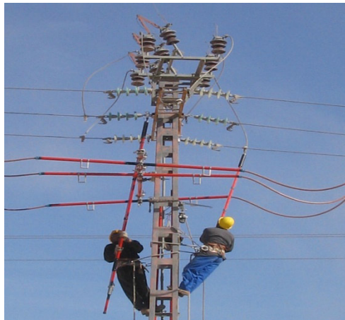
Fig.(2.1.3.2.19) :raccordé les ponts
