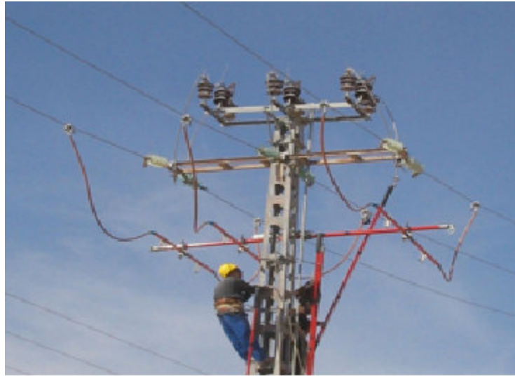
Fig.(2.1.3.2.20) : enlèvement des shunts
