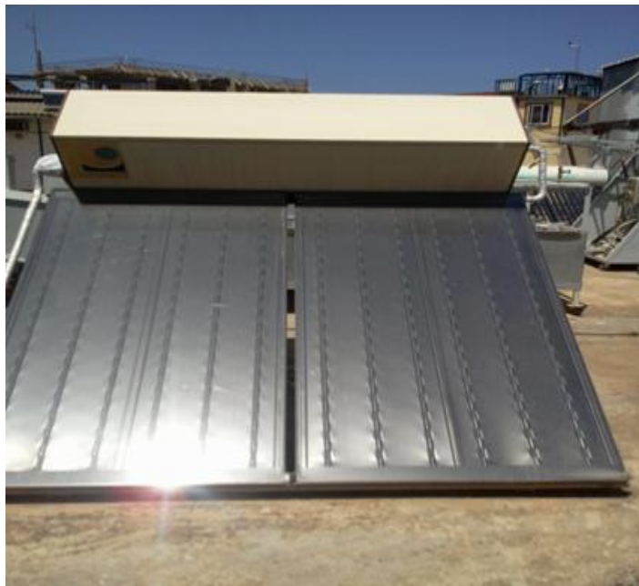
Figure 3.1- banc d'essai du CESI à BOUZAREAH
