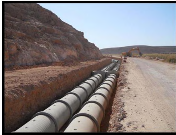
Figure II. 4 : Collecteurs d'amenée des eaux usées
