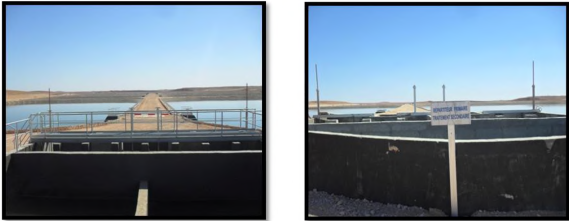
Figure II. 8 : Répartiteurs principales vers les bassins primaires et secondaires
