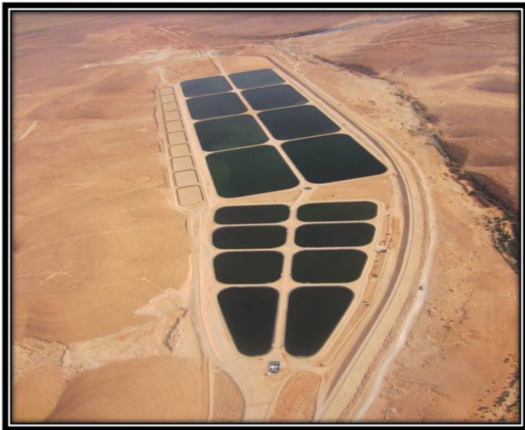
Figure II. 6 : Vue aérienne de la STEP de Ghardaïa
