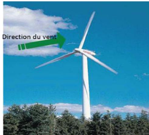
Figure I-10 : éolienne face au vent (amont) [1].
