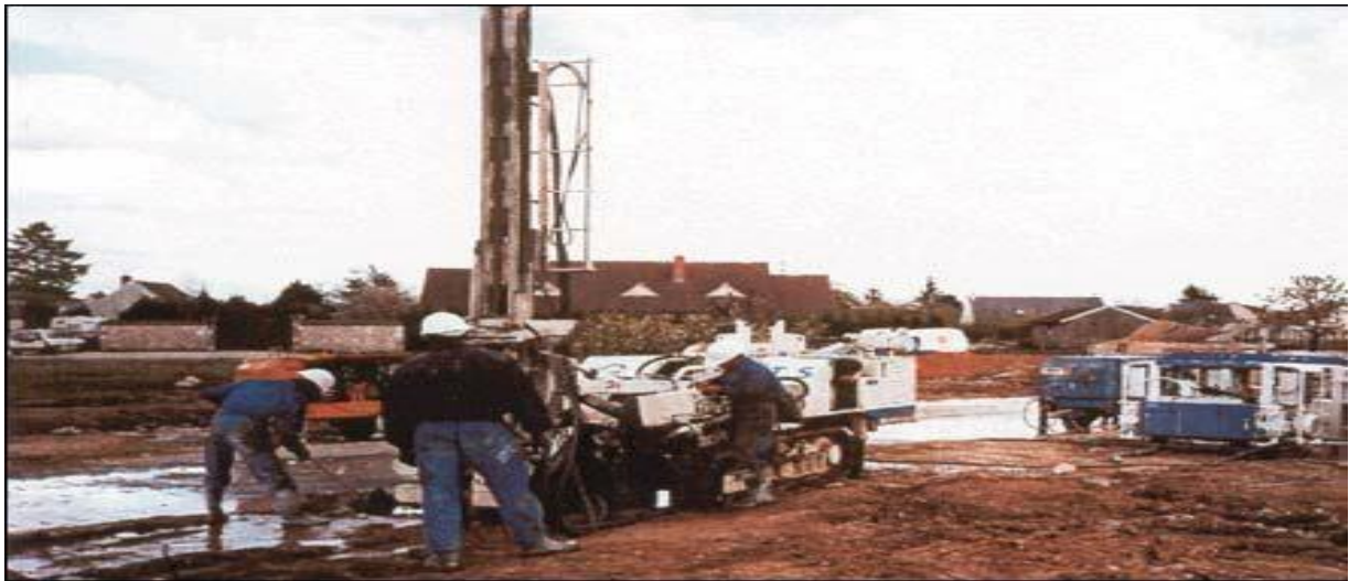
Figure 2-4: Forage de traitement d'une cavité
