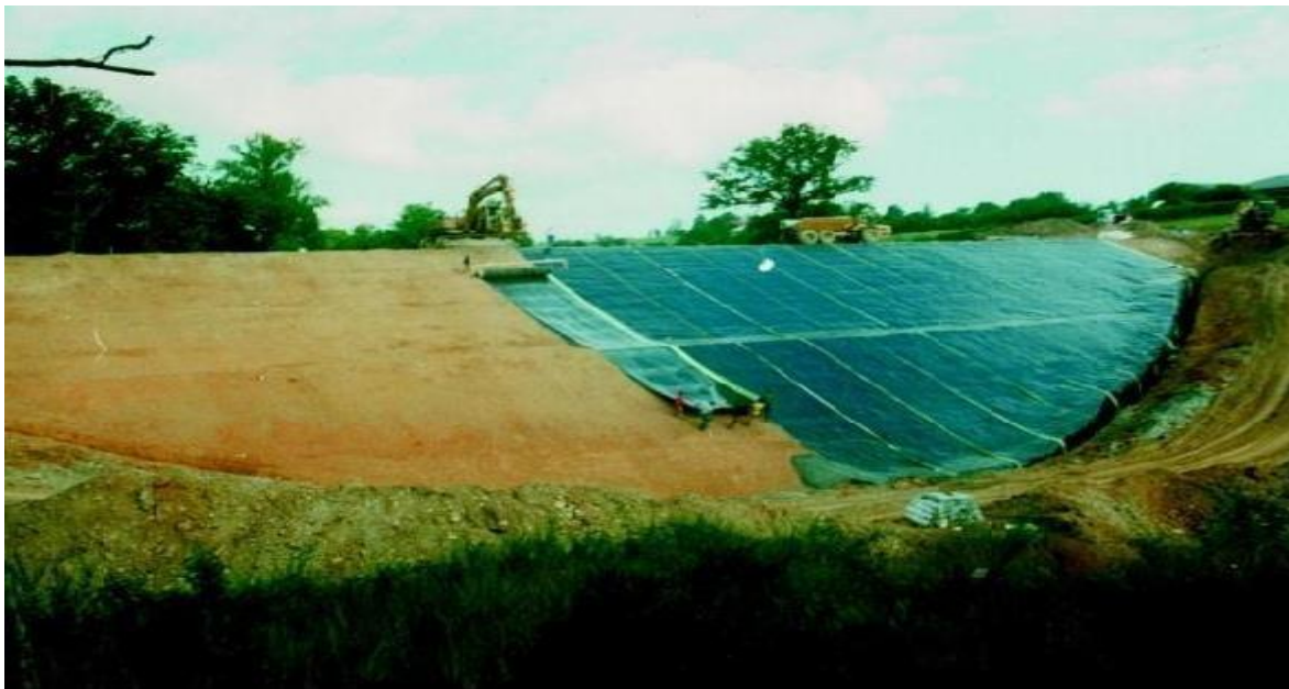
Figure 2-3: Mise en place d'une géomembrane
