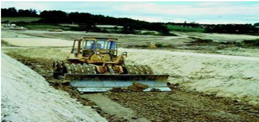
Figure 2-2: Compactage d'argile dans la clé d'étanchéité.
