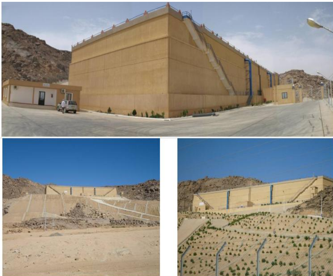
Figure (I.14) : Réservoir terminal.
