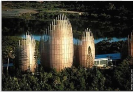
صورة 08/ واجهة مركز تيجباو المصدر http://earth-arch.blogspot.com
