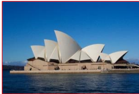
الصورة (1- II): اوبرا سيدني، استراليا، المصدر: (house Sydney 2014)
