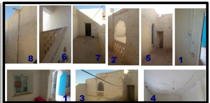
Photo N°26 : Les différentes vues du 1ère étage. /Source : Elaborer par l'étudiante.
