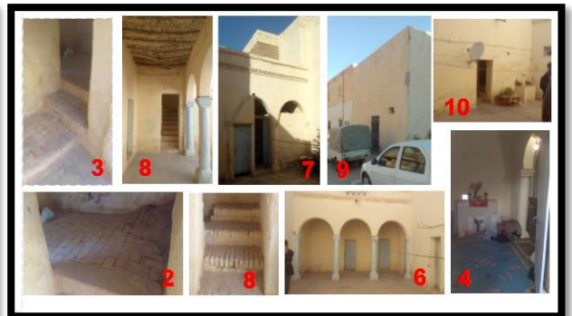
Photo N°25 : Les différentes vues de RDC. /Source : Elaborer par l'étudiante.
