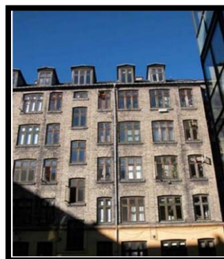
Figure N° 01 : Les façades des immeubles en cours de réhabilitation. / Source: http://www.cerdd.org .
