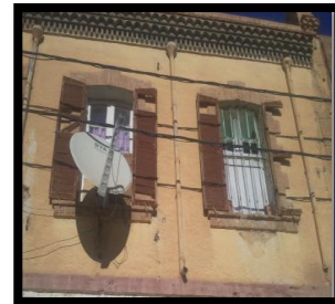
Photo N°30: Les fenêtres : d'une forme d'Arc surbaissé. /Source : Auteur.
