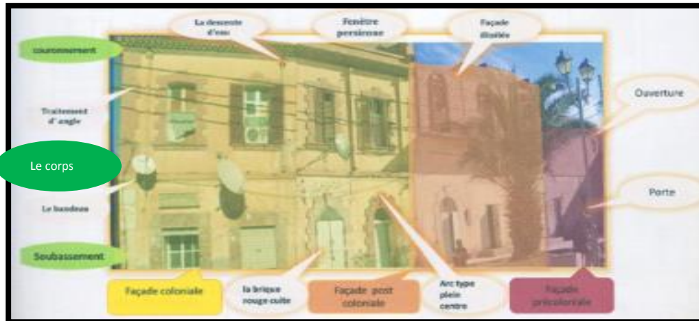
Figure N° 42: Paroi est de la place de l'Etoile. / Source : l'auteur.
