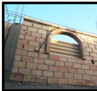
Photo N° 17: La brique creuse. /Source : l'auteur.
