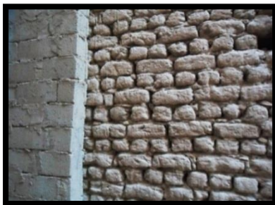
Photo N°16 : La terre cuite et parpaing
