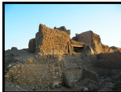
Photo N°12 : Maison construite avec la terre. /Source : l'auteur.
