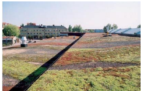
Fig1. 11 Centre de la toiture végétalisée
