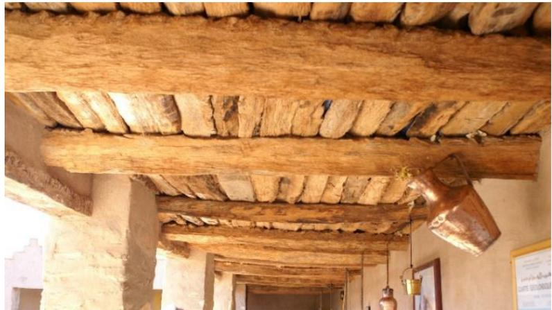
Figure 16 Toit construit par le bois de palmier (40)
