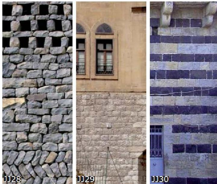
*Figure 21 Murs en maçonnerie de pierre sèche et hourdée. (40)*
