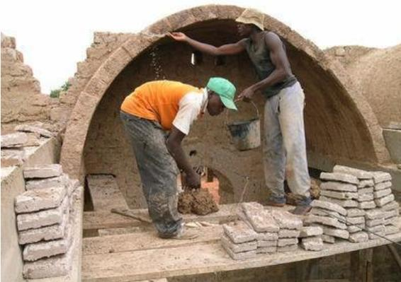
Figure 25 Construction d'une voûte nubienne (42)
