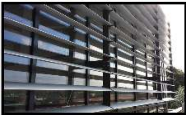
الشكل 06 : غلاف معماري بكاسرات شمس أفقية
