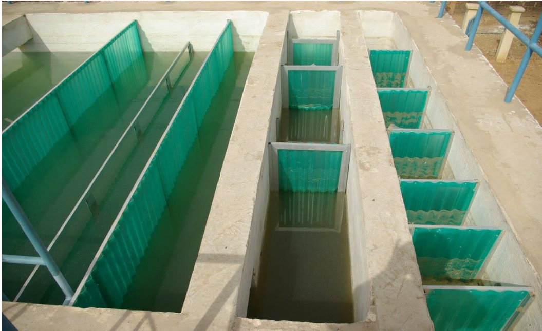
Figure 2.2 : floculateur à chicane (googlee photo)
