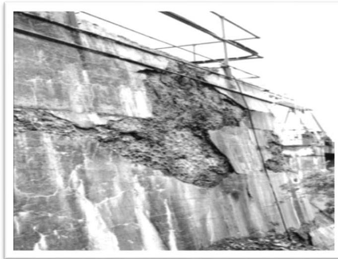
**Figure II-06 : Exemple de dommages causé par le gel-dégel [27].**
