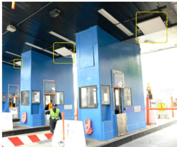
FIGURE 2.20 – RFID dans les routes
