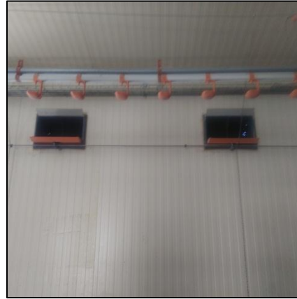
Figure 24: Trappes (vue de l'intérieur)(photo originale,2019)
