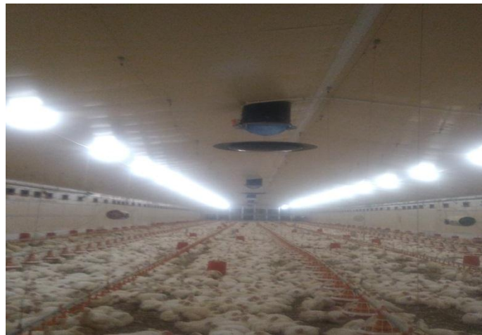
Figure 25 : Lampes d'éclairage tout au long du bâtiment (photo originale, 2019).
