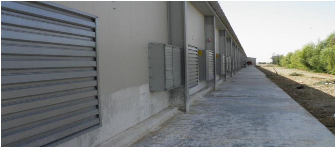
Figure 5 : Murs isolants en charpente metalique(photo originale,2019).
