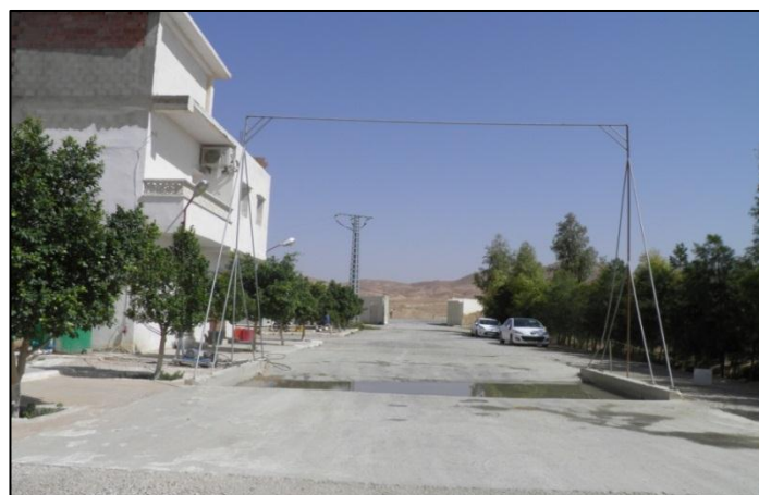
Figure22: Roto-luye à l'entrée (photo originale,2019)
