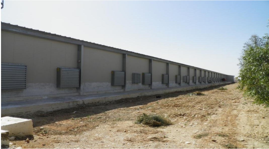
Figure 4 : Bâtiment d'élevage en batteries(photo originale,2019) .
