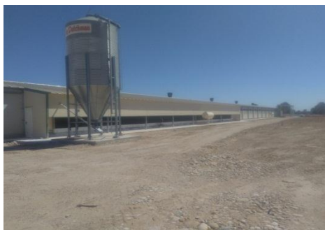
Figure27 : Le silo (photo originale, 2019)
