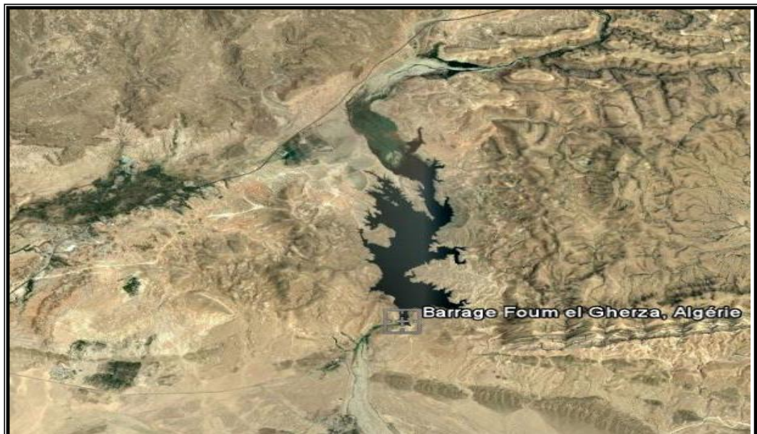
Fig.20. Image Google Earth de la retenue du barrage de Foug El Gherza (Biskra) Photo prise par Google Earth pro.
