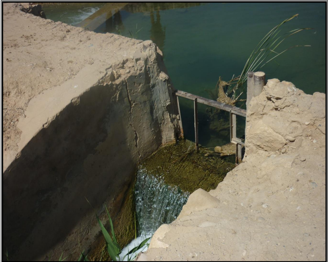
Fig.12. Porte d'eau Ciment(masraf).Avec porte en métal manuel.originale.
