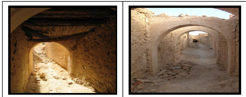
الصورة 07 : مسلك ثانوي (زقاق) داخل القصر
