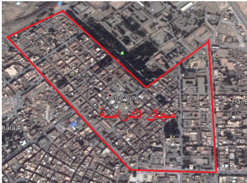
الصورة (3): توضح صورة جوية لموقع و حدود مركز مدينة بسكرة
