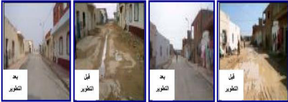
صورة رقم- 6 - حالة المباني قبل وبعد التطوير حي سيدي منصور بصفا قس بتونس-
