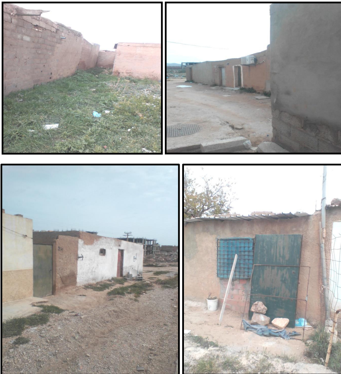
صورة رقم 21: مظهر البنايات داخل الحي
