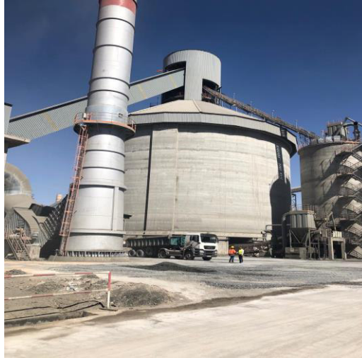
Figure I.16 : Silo de clinker.
