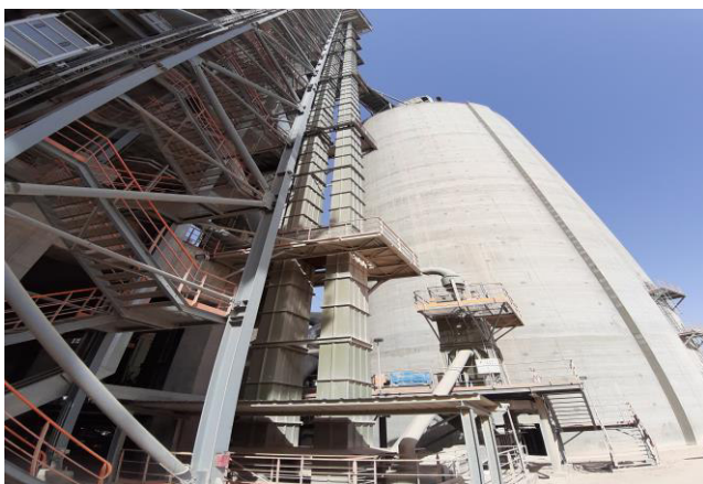
Figure I.12 : Silos homo, élévateur à gaude.
