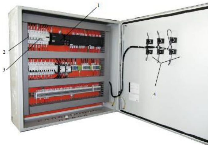
Figure II.11 : Illustration similaire d'une unité de contrôle de PLC équipé de Simatic S7. [7]
