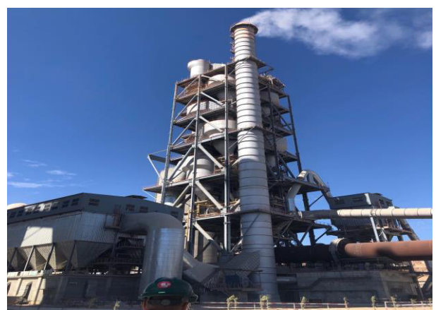
Figure I.13 : Tour de préchauffage.
