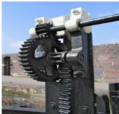
Figure I.41 : Serrure porte contrôle sur un canal
