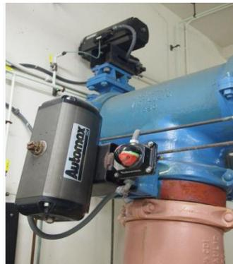
Figure 1.44 : Actionneurs pneumatiques à crémaillère.
