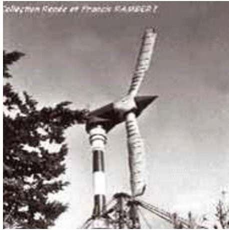
Figure 10: Eolienne de 100 kW de Grand Vent
