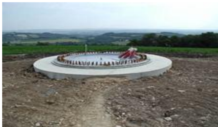
Figure 13 : la fondation l'éolienne.
