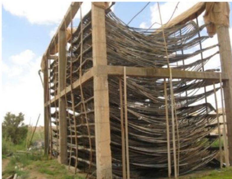
FIGURE 2.19 – L'ancienne méthode de refroidissement des eaux par cascade.
