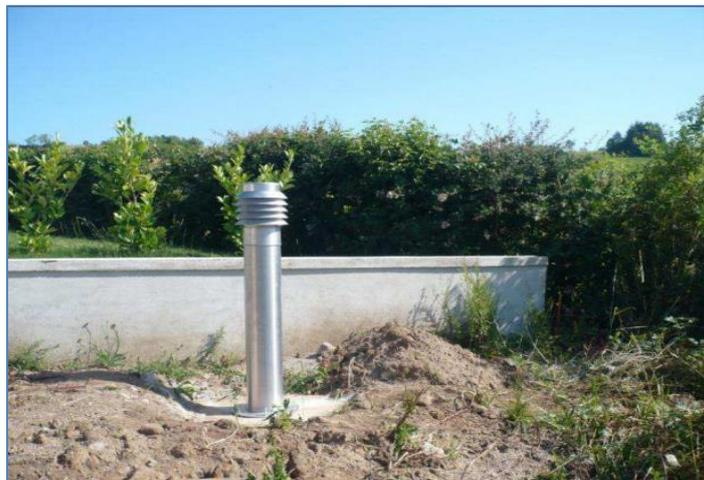
**Figure 1.11** : La prise d'entrée de l'air neuf [16].
