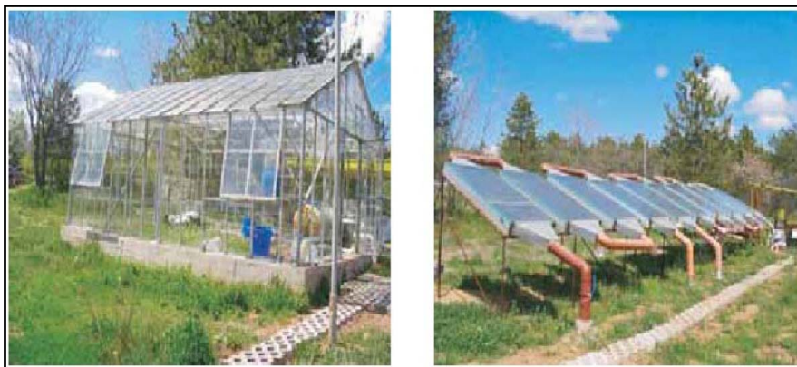
Figure(I.9): Capteur solaire à air montée en série pour assurer le chauffage d'une serre horticole en verre[1]
