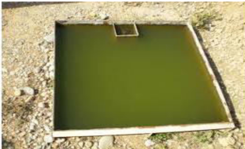
Figure I.3 : Le bac enterré
