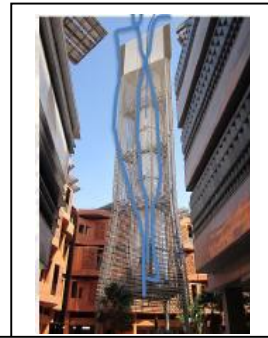
Fig.n°92 : système de climatisation. Source : (www. masdarcity.ae)
