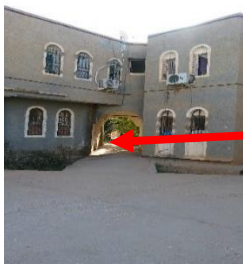
Fig.n°144 : les utilisations du passage couvert. Source : (l'auteur, 2019)
