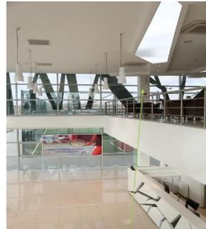
système poteaux – poutre en béton armée
