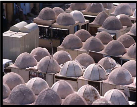
صورة13:توضح تموضع القباب في بناء السوفي المصدر:مدرية الثقافة الوادي
