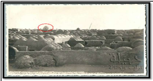
صورة 3: توضح موقع مسجد علي بن خزان في النسيج العمراني
