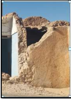
الصورة33:توضح سمك الجدار المصدر:الباحث 2019
