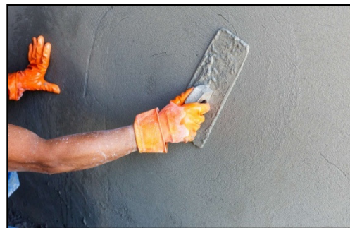
Photos 38 : mortier de chaux, crépissage
