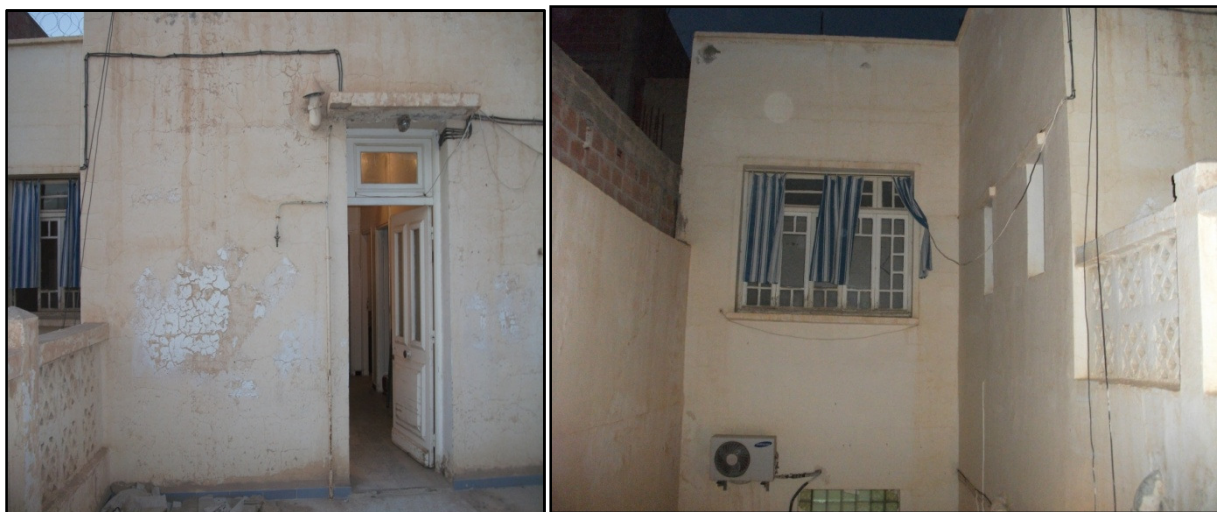
Photos 26 : Photos du 1 er étage sur terrasse
