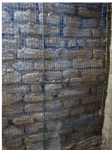
Photos 39 : support d'adhésion de l'enduit de chaux
