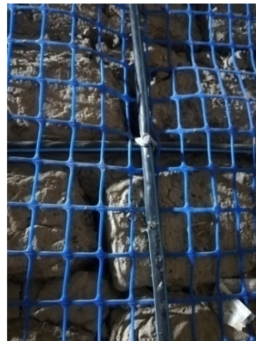
Photos 39 : support d'adhésion de l'enduit de chaux
