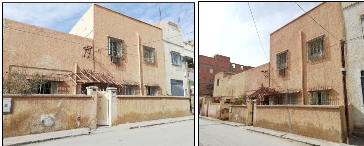
Photos 20 : vu sur facade
