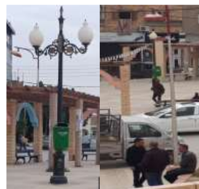
Figure N°12: photos condelabre d'éclairage d'ambiance et condelabre d'éclairage extérieur
