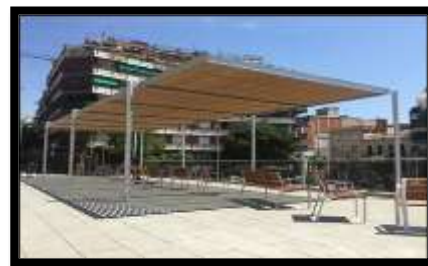
Figure N°28 : Abri (Pergola) dans la place publique (Barcelone).
