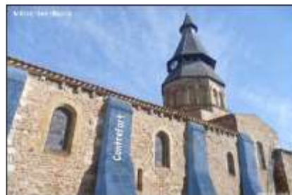
Figure N°40 : Le contrefort Source : www.caue03.com (Google images)
