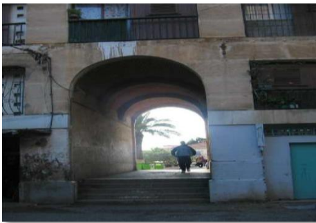
Figure 55 : passages couverts Source: l'auteur Le 08/11/2018
