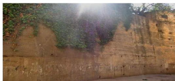
Figure 47 : murs de soutènement
