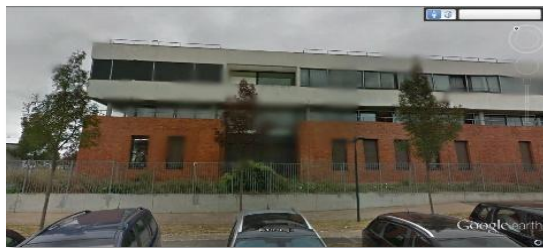
Figure 21 : Façade extérieure Source : Google
