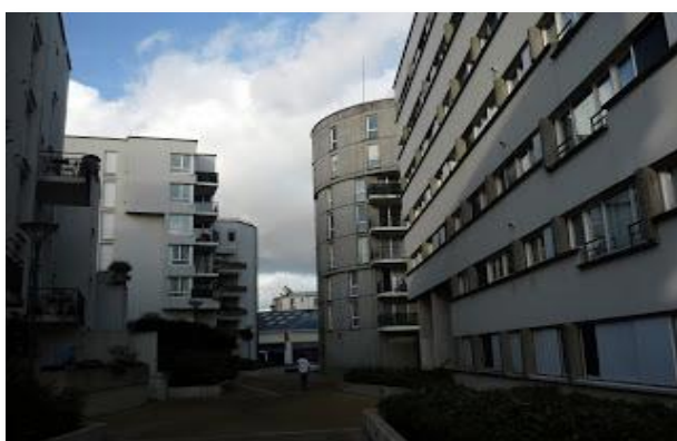
Figure 28 : entrée principale d'îlot Kerigonan Brest (France) Source : site pss-archi.eu.
