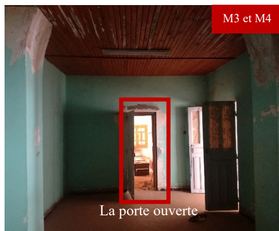
Fig. 76 : vue sur le faux plafond et la porte rajoutés.
