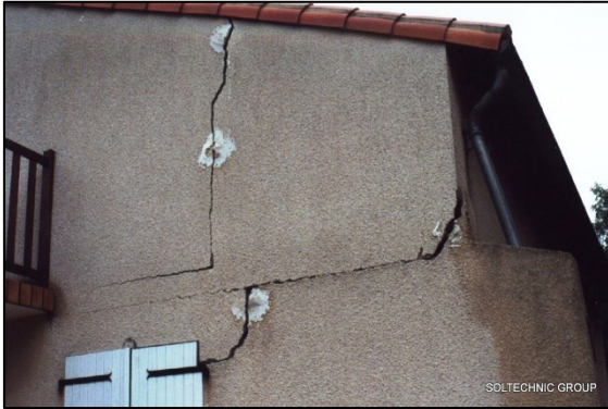
Fig. 134: Le traitement des fissures.
