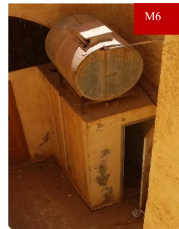
Fig. 78 : vue sur le sanitaire ajouté.
