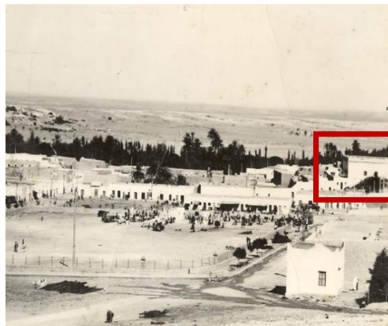
Fig. 46 :vue de la maison du caïd Senoussi
