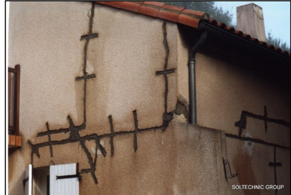
Fig.135 : Le traitement des fissures.
