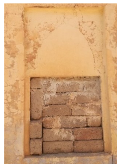
Fig. 82 : vue sur la fermeture totale de la fenêtre.
