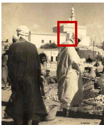
Fig. 64 : vue sur la maison de commandement.
