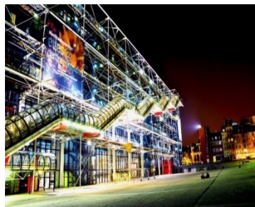
Fig. 141 : centre de Pompidou
