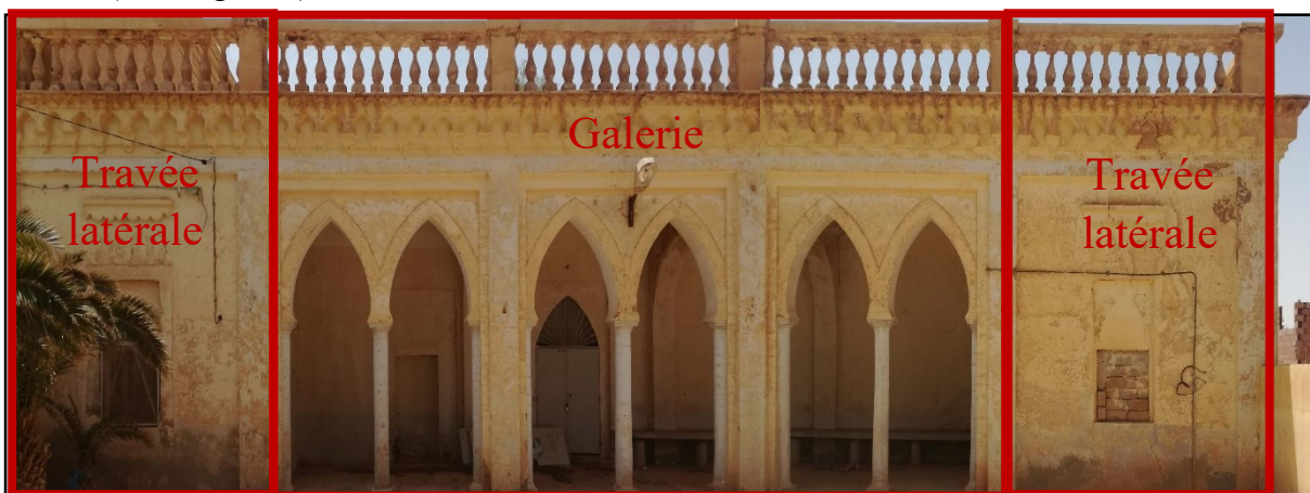
Fig. 102 : Façade principale de la maison,
