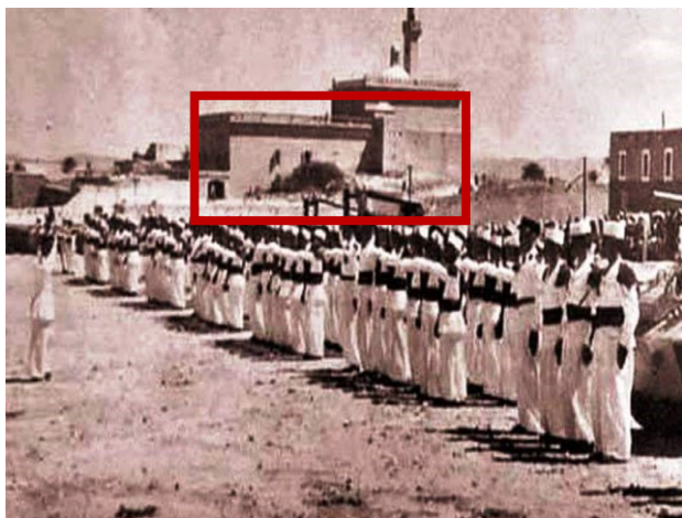
Fig. 45 : Vue de la maison du caïd Senoussi
