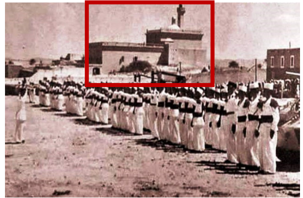
Fig. 61 : vue sur la maison de commandement.
