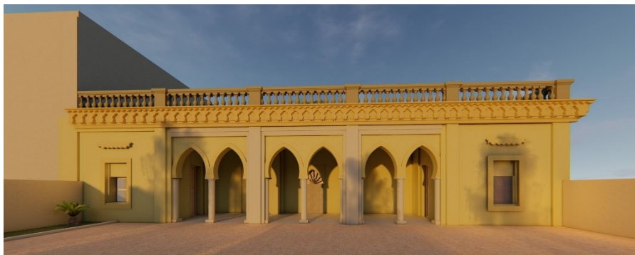
Fig. 101 : vue en 3d sur la façade principale de la maison de commandement
