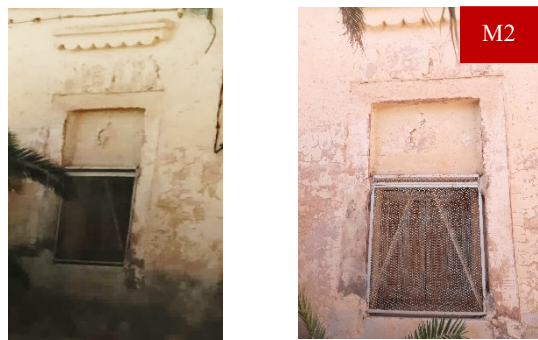
Fig. 75 : la fermeture partielle de la fenêtre.
