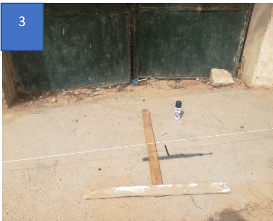
Fig. 87 : L'entrée à travers le portail principal,
