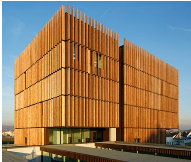
Figure II-69 : Façade à lamelles.
