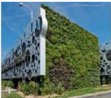
Figure II-34 : La façade végétalisée.
