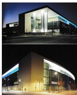
Figure IV-2 : La signalisation de l'entrée. (Source : 25 centres commerciaux p.108, p.90, p.46 et p.80).
